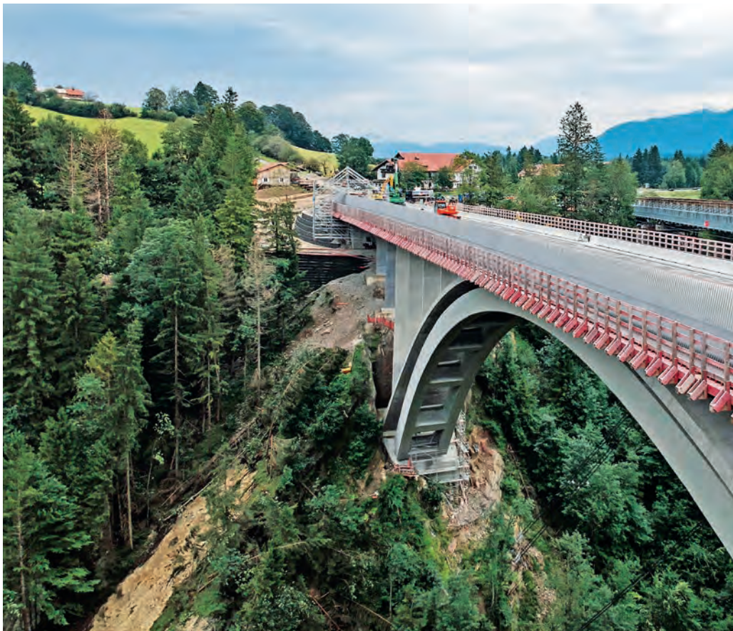
Die Echelsbacher Brücke überspannt die Ammerschlucht in bis zu 80 m Höhe über dem Talgrund. Sie gilt als die größte Melan-Bogenbrücke der Welt mit einer Spannweite von 140 m.
