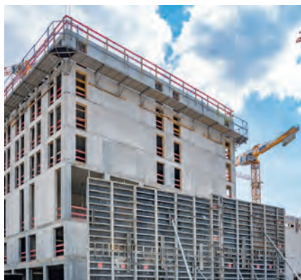
Großflächiges Schalen an der Wand mit kranabhängiger Manto-Rahmenschalung: Selbst im aufgestockten Zustand ist sie für Betondrücke bis 80 kN/m 2 auslegt.
