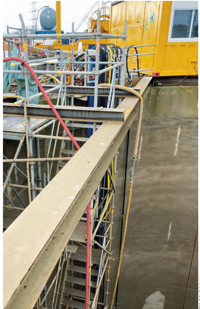
Aufgehängter Treppenturm
