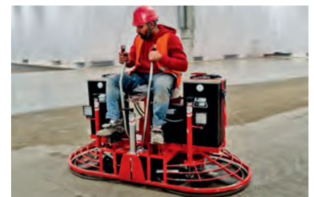
Bei der siebenstündigen Bearbeitung des Bodens musste beim A536-2 nur dreimal der Akku gewechselt werden.
