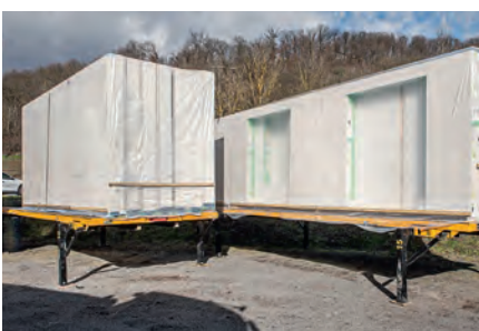
Die Wandelemente sind fertig zum Transport auf die Baustelle.
