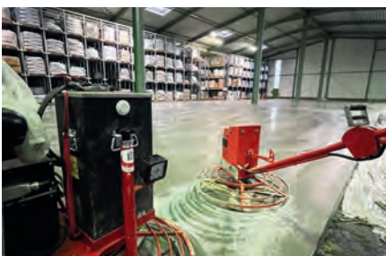
Ein Akku-Flügelglätter und ein Akku-Doppelglätter beispielhaft im Einsatz
