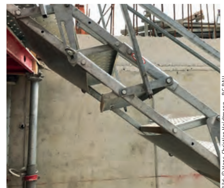
Treppe mit nivellierbaren Stufen im Montagezustand, durch Anbauteile verlängerbar
