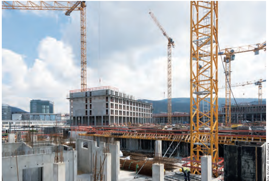
Großbaustelle „Europaplatz“ Heidelberg: Alle fünf Gebäude des neuen Quartiers entstehen gleichzeitig.
