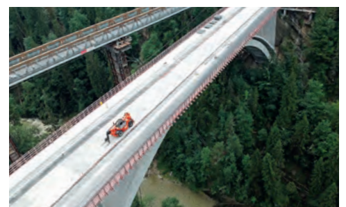
Nur die denkmalgeschützten Melan-Bögen blieben von der alten Konstruktion erhalten.
