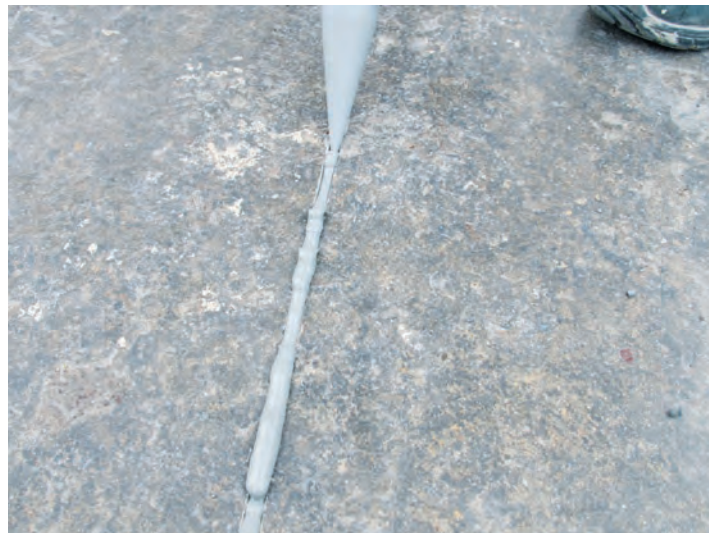
Einbringen von elastischem Dichtstoff in die Bewegungsfuge einer Beton-Verkehrsfläche
