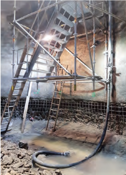
Aufgehängter Treppenturm mit temporärem Übergang
