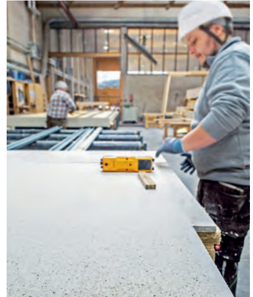
Montage der Gipsfaser-Platte
