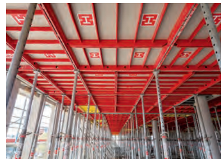
Zur Schalung der Regelgeschoss-Decken sind 11.000 m 2 der handbedienbaren Topec-Modulschalung im Dauereinsatz.
